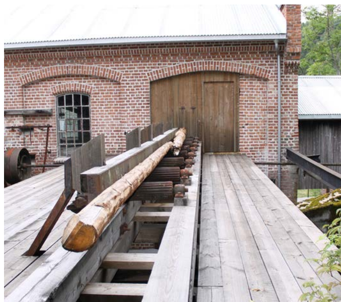
Tømmerinntaket etter restaurering.
