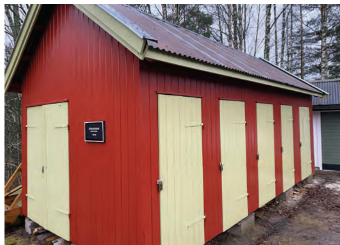
Etter oppussing av Jernbodene.
